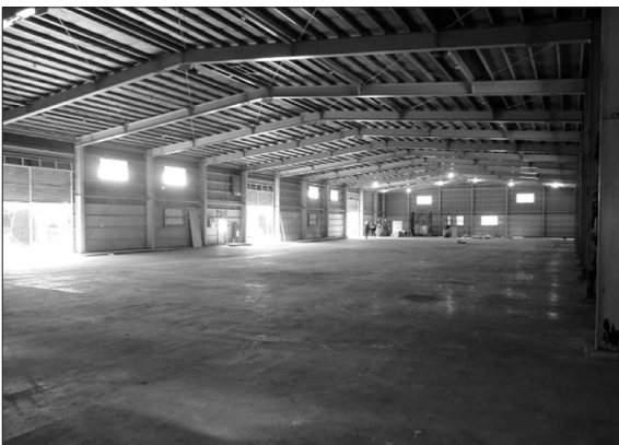
図1 2013年5月大型物流倉庫を改築
